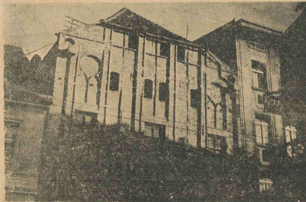
Fasada domu gotyckiego przy ul. Chełmińskiej, oczyszczonego już z tynku.
