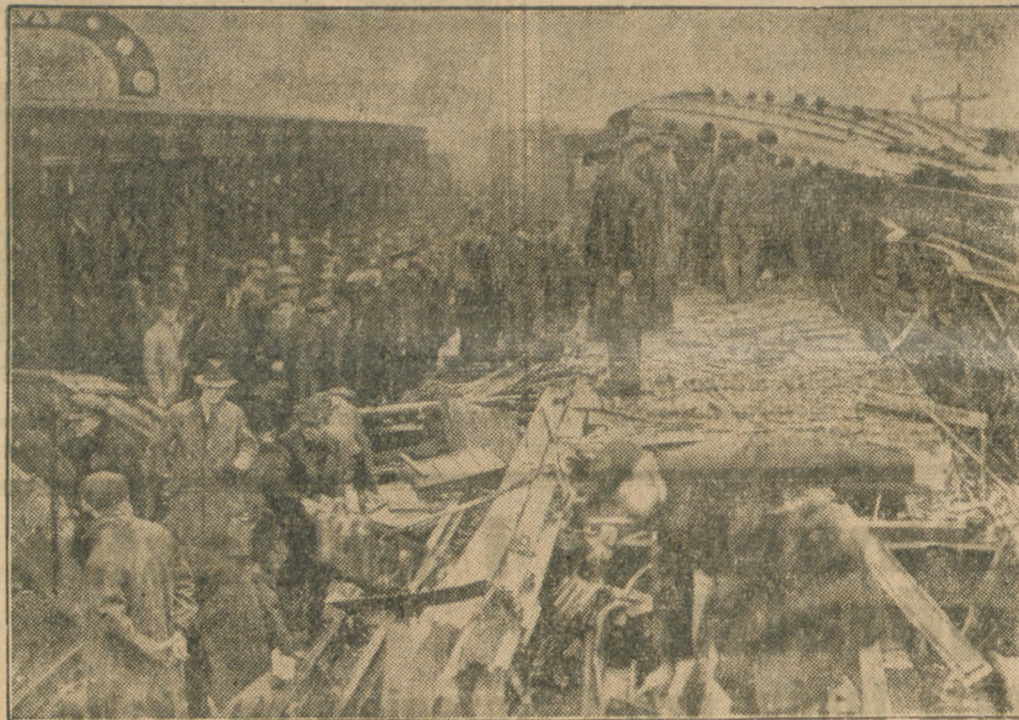
Szczątki pociągu na moście w pobliżu stacji Battersea Park
