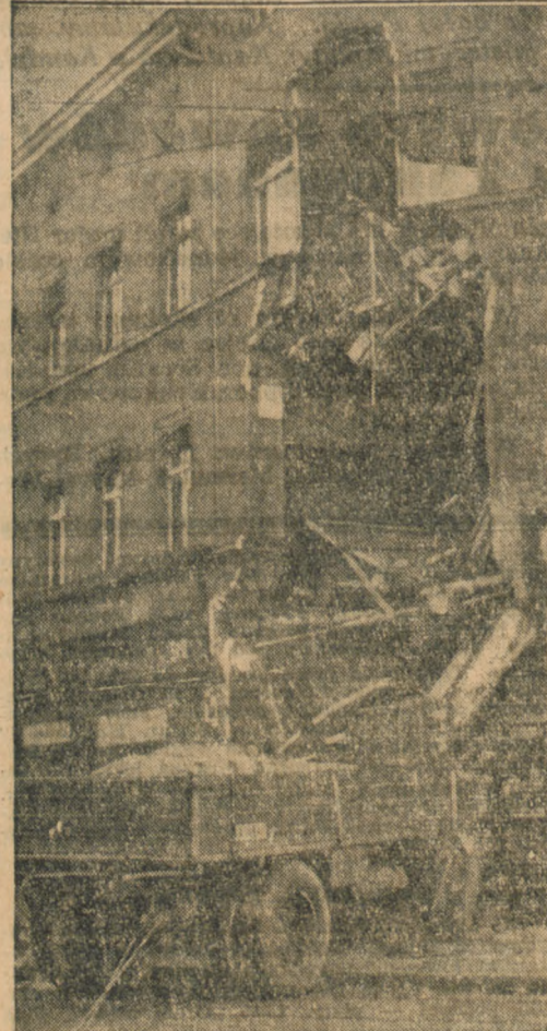
nego samochodu wraz z przyczepką, na której znajdowało się 300 ctn. zwier, najechał na narożnik domu. Samochód przebił front znajdującą się tam sklepu do głębokości 3 metrów i zламаł podporę narożnika. Cały narożnik 4-piętrowego domu zawalił się.
