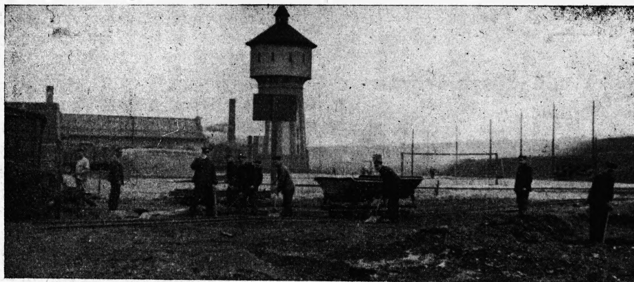
Członkowie Ogniska K. P. W. Tczew II przy budowie boiska sportowego.
