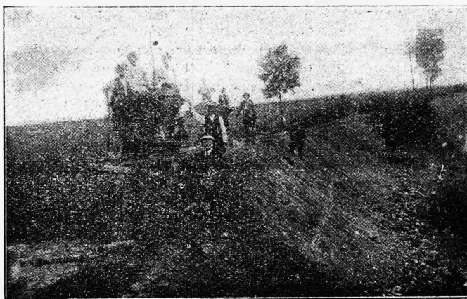
Strzelcy z Glińska przy naprawie drogi Glińno-Borzyszkowy.
