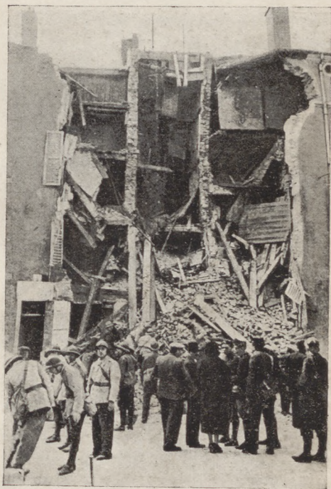
Przekrojona bombą trzypiętrowa kamienica.
