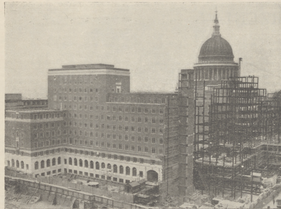
Bank of England, który tak niedawno był punktem powszechnego zainteresowania w związku z zagrożoną pozycją funta, ma przenieść część swoich działów do nowego gmachu. Na zdjęciu widać rozpoczętą już budowę obok katedry św. Pawła.
