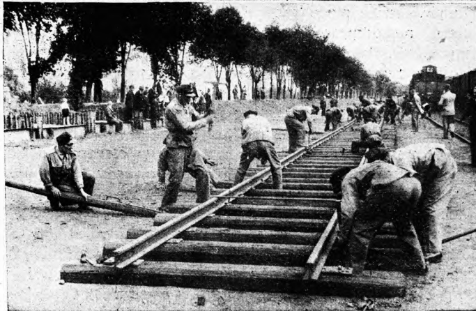
ĆWICZENIA TECHNICZNE CZŁONKÓW K. P. W. Układanie toru kolejowego.
