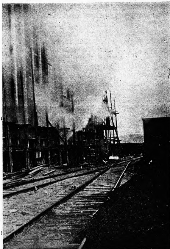
Fragment z nowowbudowanej elektrowni.
