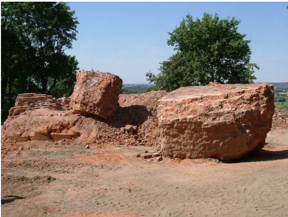
2. Odlamki z rumowiska wieży Klimek. Stan z 4.07.2006 r. Po prawej stronie odlamek z wiązaniem opus rusticum . Z lewej strony fragment wnęki oświetleniowej z wnętrza wieży. Fot. M. Szajerka.
