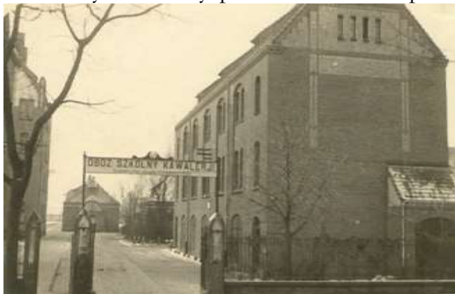
Przedwojenne obiekty Centrum Wyszkozenia Kawalerii (obecnie siedziba JW 1109) w Grudziądzu.
