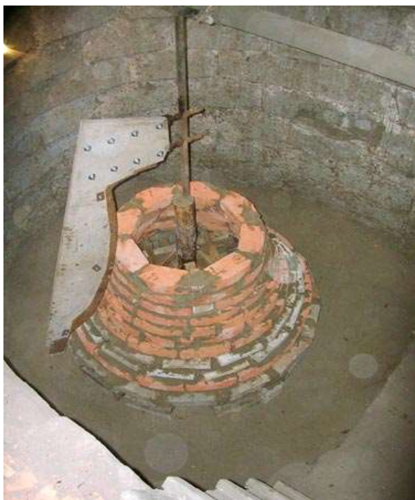
Początek budowy dzwonu.
