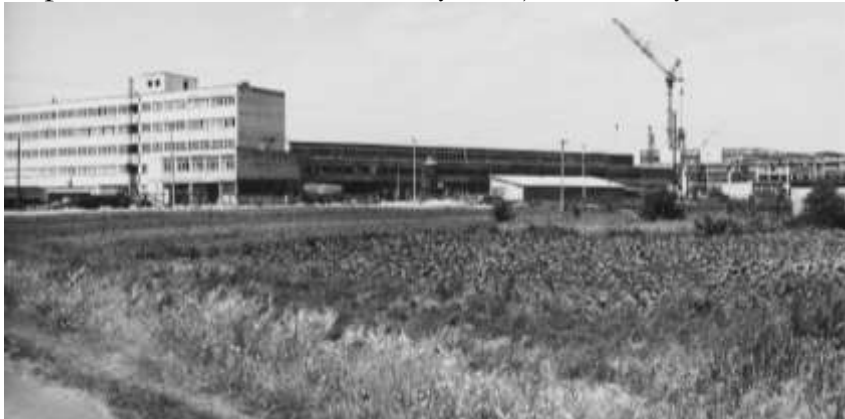
WARMA w budowie
