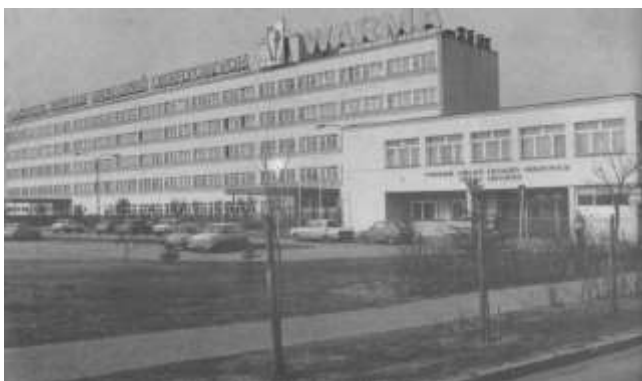
Nowa siedziba Pomorskich Zakładów Urządzeń Okrętowych WARMA w Grudziądzu
