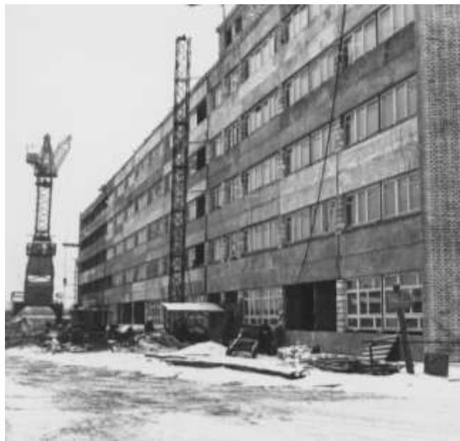
Budynek administracyjny WARMA w budowie
