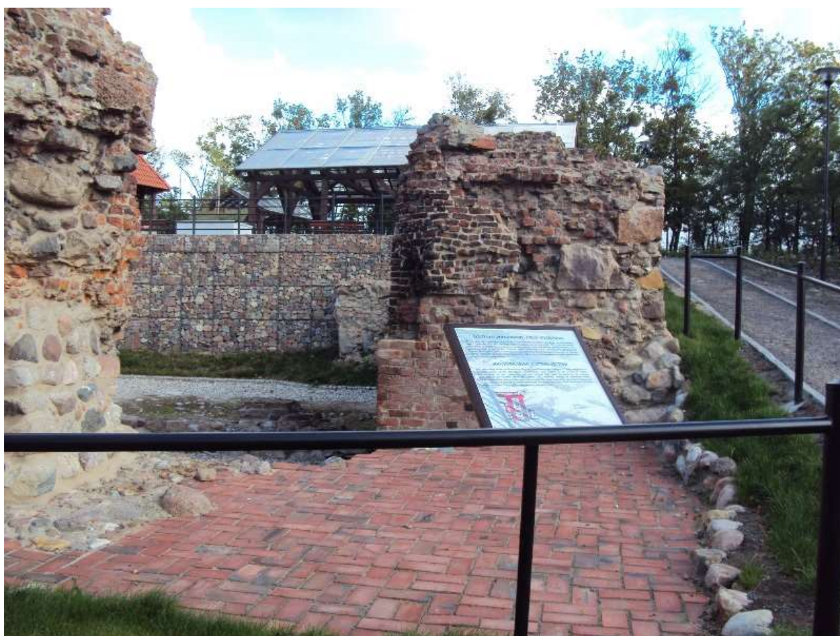
Narożnik skrzydła południowego Zamku Wysokiego. Stan 2015 r. Fot. M. Szajerka.
