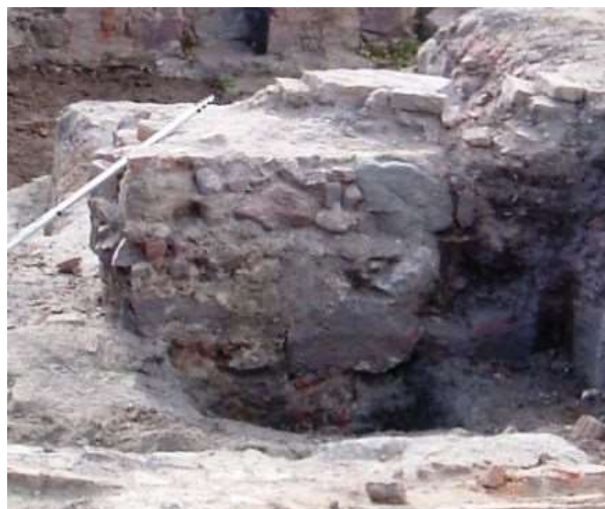
Fundament przy kominie. Stan w 2009 r. Fot. M. Szajerka
