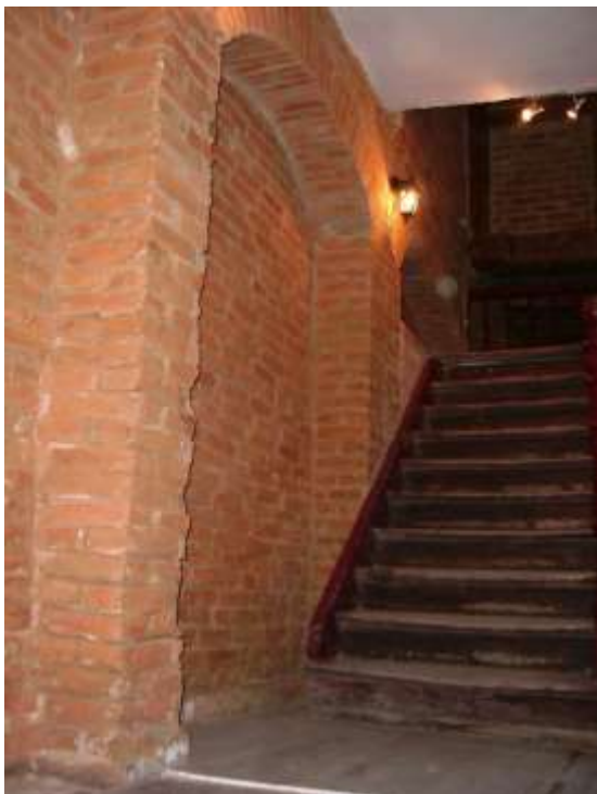
Fragment blendowanego muru obronnego z XIV w., z wiązaniem wozówkowym, ul. Kościuszki 31 w Grudziądzu.
