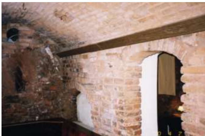
Kamienica przy ul. Wieżowej 2. Pomieszczenie z fragmentem łuku odciążającego.
