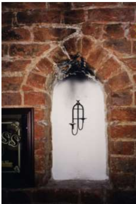
Wnęka oświetleniowa w murze z wiązaniem wendyjskim. Pierwotnie prawdopodobnie okno późnoromańskie, z 2 poł. XIII w.
