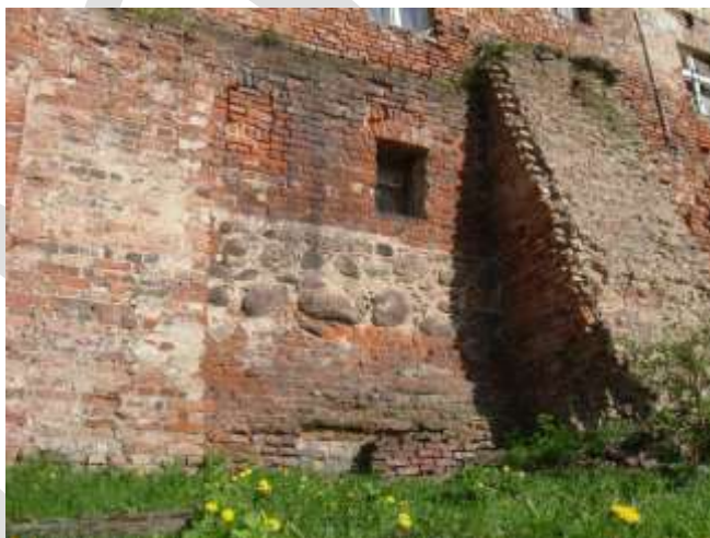
Ściana spichrza od strony Wisły, z „odwróconym” porządkiem chronologicznym wątków. Na dole, jako najstarszy jest tu przypuszczalnie wątek krzyżowy. Wątek gotycki jest tu ozdobny, wykorzystaniem cegły zendrówki, ciemno wypalanej.
