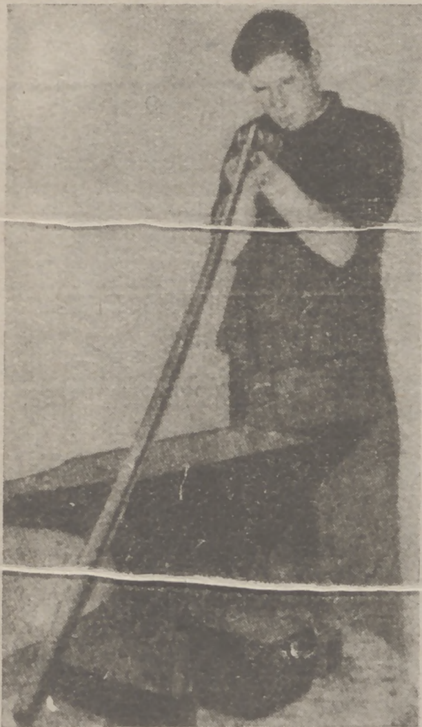
Rys. 189 Zgięcie pręta stwierdzamy patrząc wzdłuż jego osi
