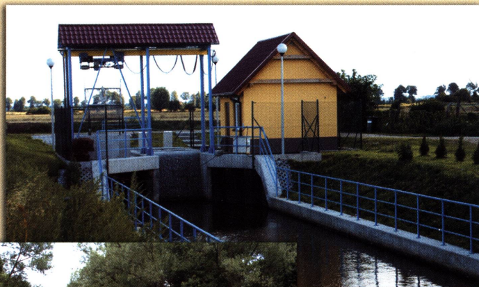
Pompownia przeciwpowodziowa Kąty
