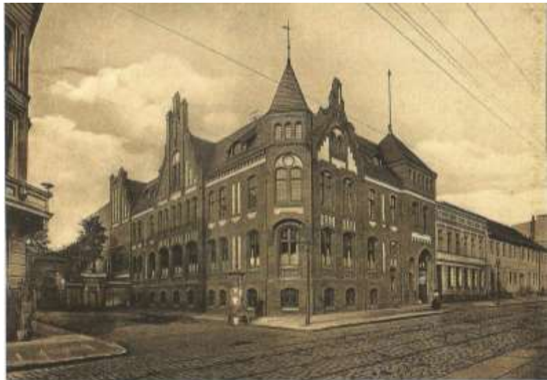
Nowy biurowiec fabryki w Grudziądzu z widocznym wejściem głównym (po prawej)
