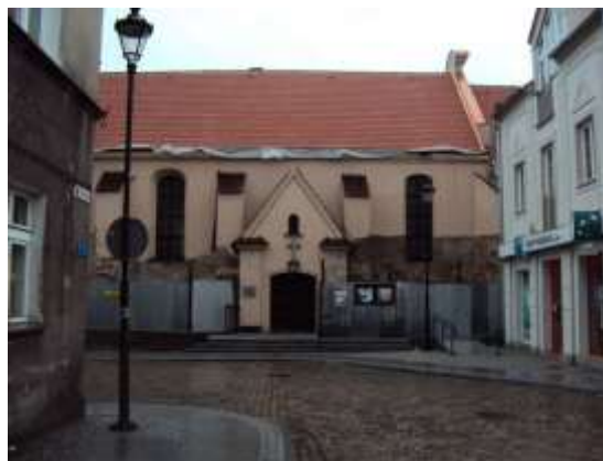
Kościół Św. Ducha, ściana północna 23.12.2014 r. Fot. M. Szajerka.
