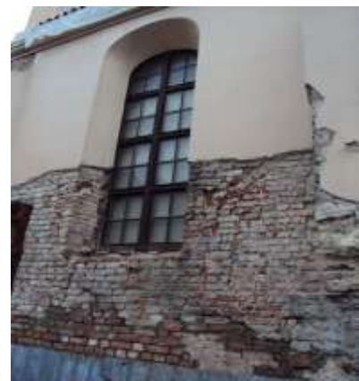
Ściana północna, po lewej stronie kruchty, relikw okna. Stan na 23.12.2014 r., Fot. M. Szajerka.
