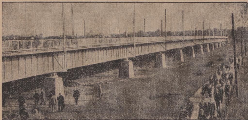
W Dreźnie został poświęcony nowy most, który jest największym w Europie mostem bez nitów. Poszczególne części stalowe spajano za pomocą elektryczności. Zaoszczędzono w ten sposób około 15 proc. ciężaru. Długość mostu wynosi 315 m.
