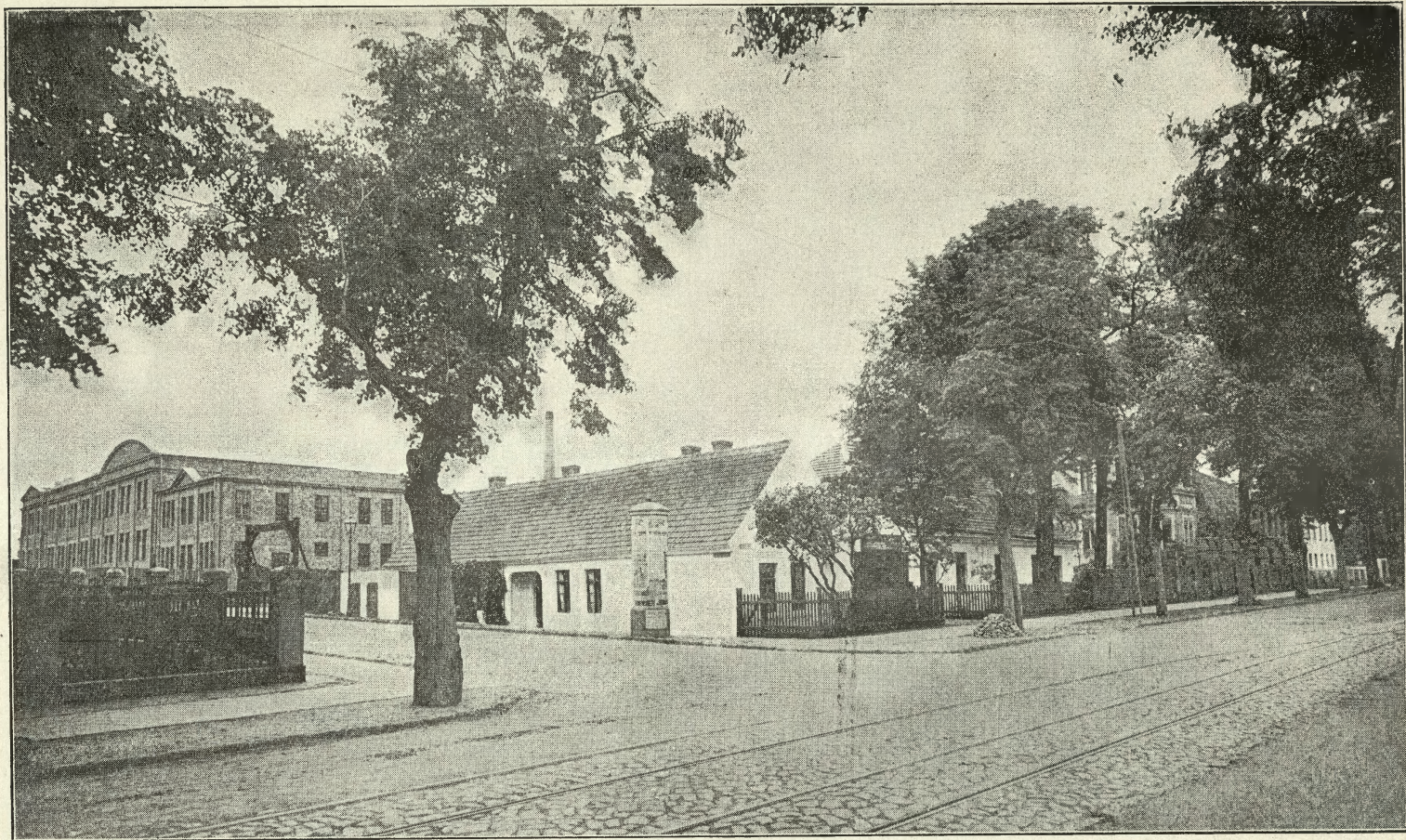
Widok zewnętrzny ogólny. — Total-Ansicht. — Vue complète extérieure.
