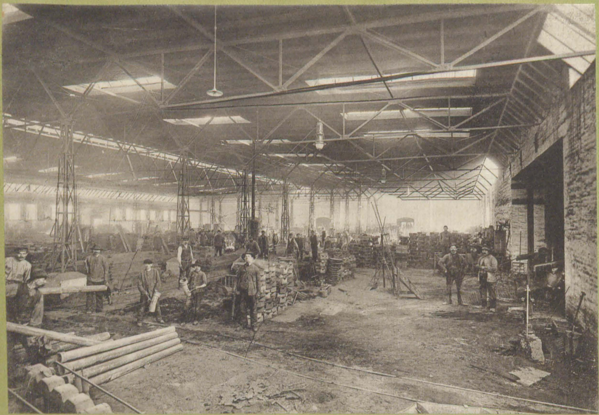
GIESSEREIHALLE IM WERK MISCHKE
