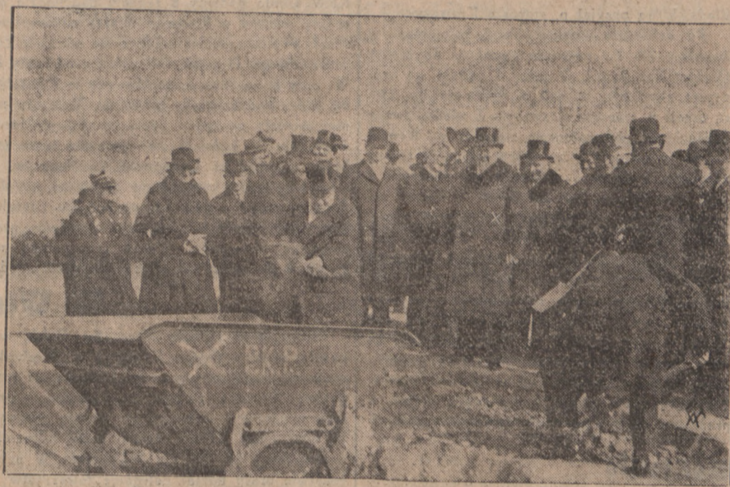
W niedzielę odbyła się na Okęciu o godz. 11 rano uroczystość poświęcenia rozpoczęcia robót i budowy linii kolejowej Warszawa — Radom. Na uroczystość przybyli: p. premier Prystora, marszałek Sejmu Świtalski, — ministrowie Butkiewicz, Hubicki i Zarzycki, oraz liczni wyżsi urzędnicy państwowi. Liczne zgromadzona okoliczna ludność brała również udział w uroczystości. Na zdjęciu naszym widzimy p. premiera Prystora (x) oraz ministra Hubickiego, dokonującego symbolicznego rozpoczęcia robót rzucając pierwszą łopatę ziemi.
