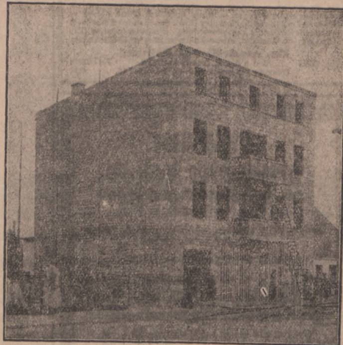
Nowa budowa p. Anieli Jahns, kupcowej, Brodnica 18 Stycznia 11 (Surowa budowa)
