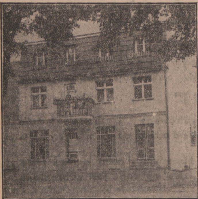
Nowa budowa p. Władysława Szulca, rewidenta wagonów, Chylonja, pow. Morski, Szosa Gdańska.
