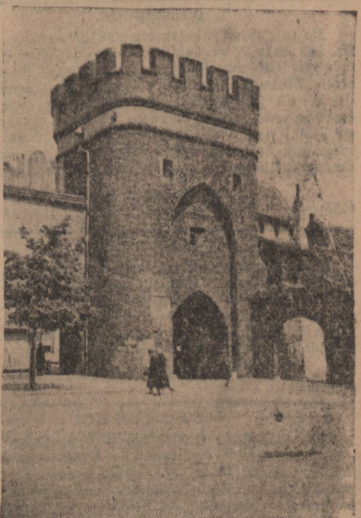
Pięknym uzupełnieniem starych murów obronnych Torunia są doskonale zachowane bramy forteczne. Oto jedna z nich: Brama Mostowa.
