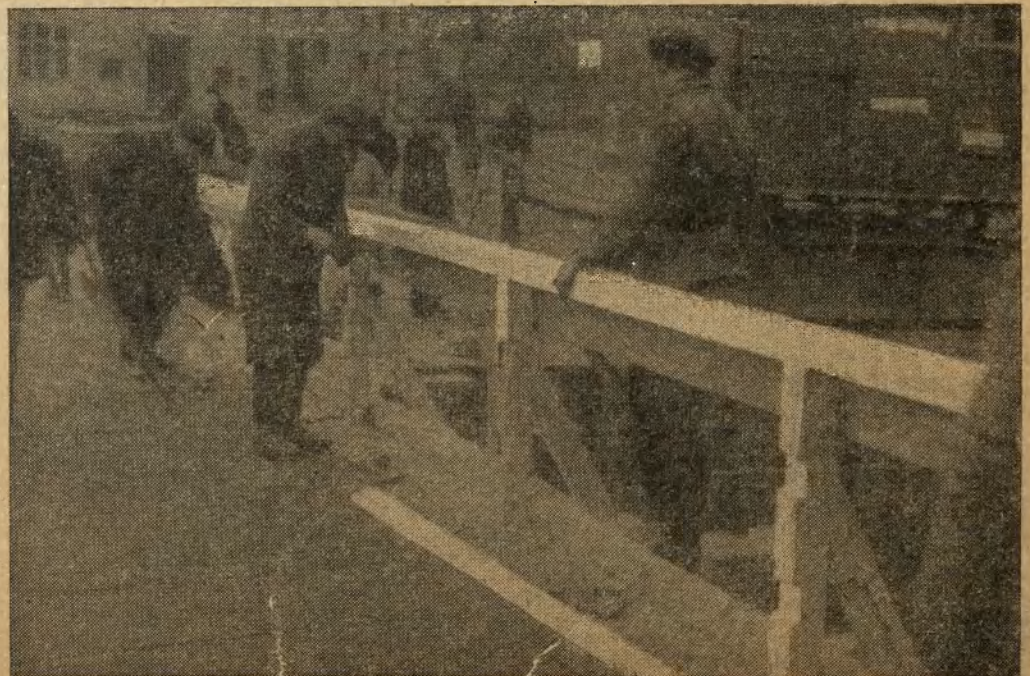
Prowizoryczny most w pobliżu wybudowanego w powietrze mostu teatralnego
