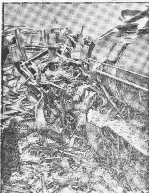
Katastrofa spowodowana wielką śnieżycą na linii Cambridge — Londyn. Zderzenie pociągów spowodowało śmierć 2 osób.
