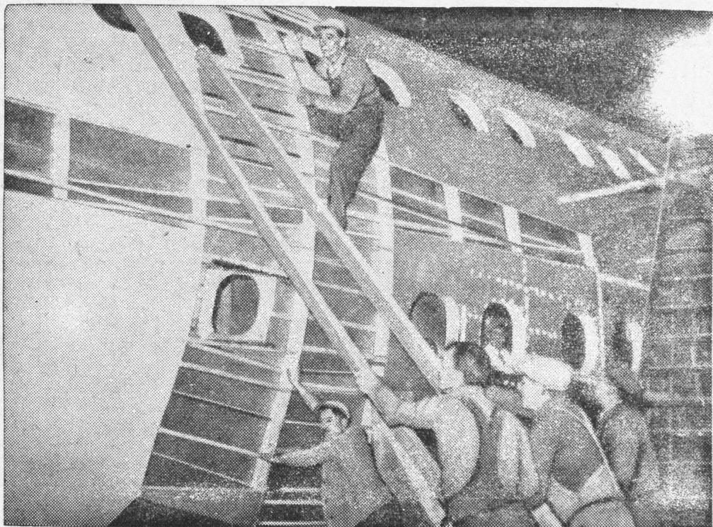
Kadłub hydroplanu francuskiego, obecnie montowanego, który będzie stanowił jeden z okazów na przyszłej paryskiej wystawie lotniczej.
