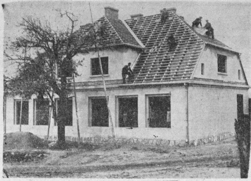
Budynek pod dachem. Publiczna szkoła powszechna w Nielbarku, pow. lubawski, wzniesiona z pomocą Towarzystwa Popierania Budowy Publ Szkół Powszechnych
