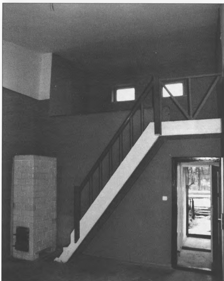
Il. 27. Widok na antresolę w budynkach przy ul. Lotniczej Źródło: Karta Ewidencyjna Zabytków Architektury i Budownictwa dla zespołu mieszkaniowego Towarzystwa Osiedli Robotniczych (T.O.R.), wyk. przez W. Romaniaka w 2008 r., w zbiorach Miejskiego Konserwatora Zabytków w Grudziądu.
