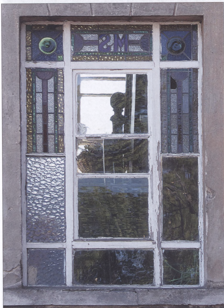
Il. 8. Okno w budynku przy ul. Piłsudskiego 78, teren dawnego folwarku Kuntersztyn, stan z 2016 r. Fot. I. Fijałkowska
