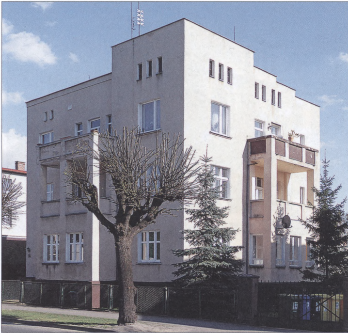
Il. 9. Budynek przy ul. Piłsudskiego 72, teren dawnego folwarku Kuntersztyn, stan z 2016 r. Fot. I. Fijałkowska
