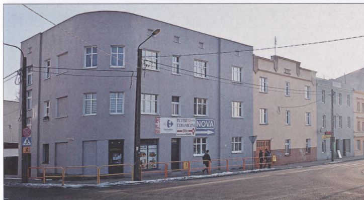
Il. 15. Budynki przy ul. Konarskiego 1, 3, 5 z ok. 1936 r., stan z 2015 r. Fot. I. Fijałkowska
