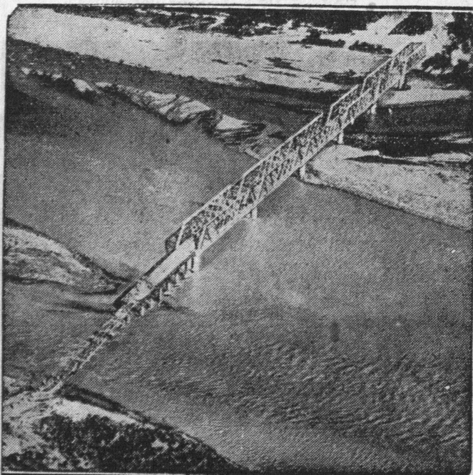
Na początku grudnia wyspy Filipiny na Oceanie Spokojnym nawiedziła wielka powódź, która pociągnęła bardzo dużo ofiar. Na zdjęciu wielki most w pobliżu Bayanbong, który został częściowo zniszczony.
