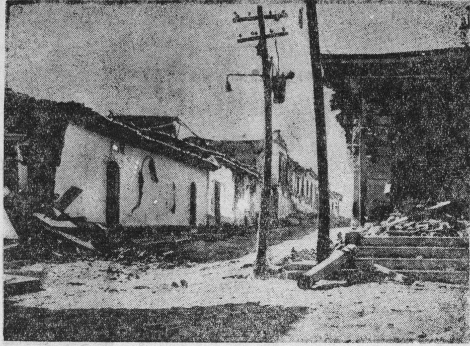
Środkowo-amerykańską republikę Salvador nawiedziło ostatnio silne trzęsienie ziemi. Oto widok pewnej ulicy po katastrofie.
