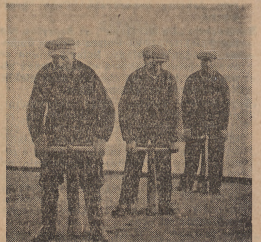
Wesoło dzwonią żelaza ubłgaków podczas ostatniego stadium budowy ulicy.
