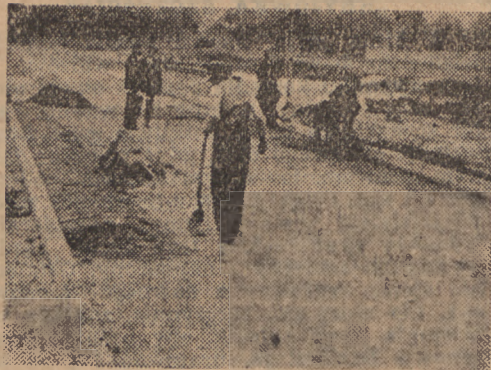
Fragment ostatnich prac przy budowie Alei 700-lecia.
