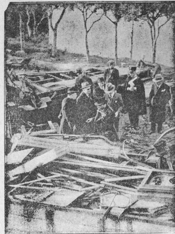
Szczałki rozbitego wagonu kolejki linowej na Wewzujszu. 7 osób poniosło śmierć.
