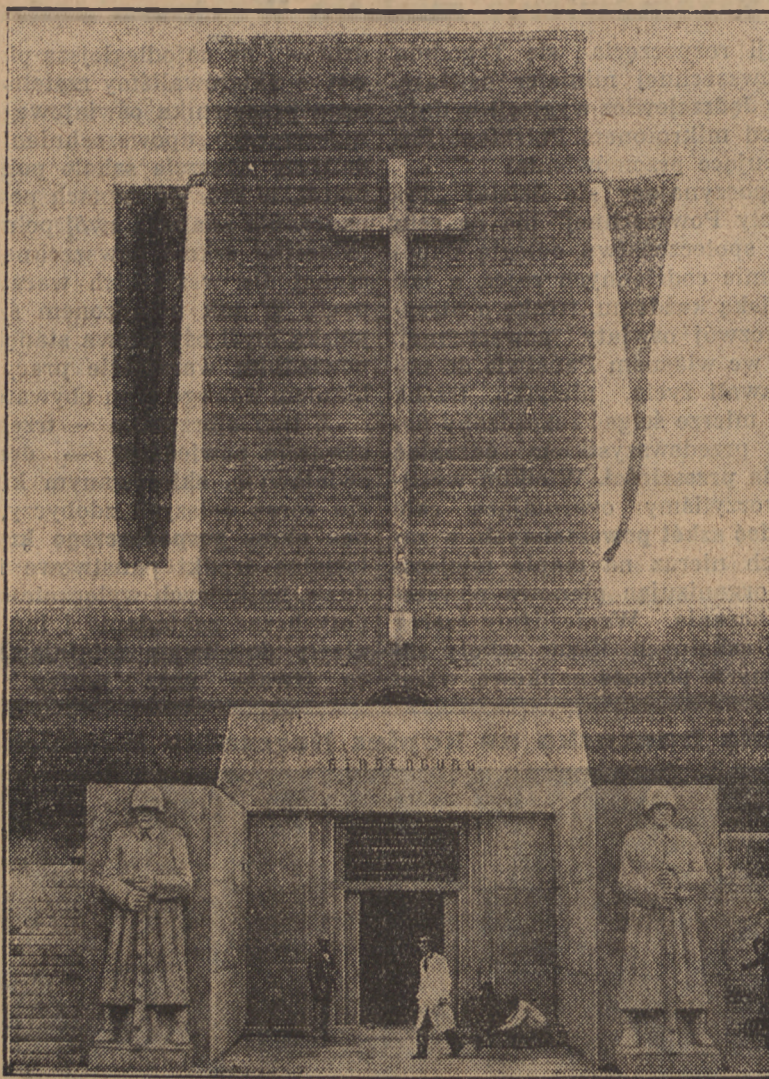
W Tannenbergu we wieży Hindenburga, będącej częścią wielkiego pomnika ku upamiętnieniu bitwy w r. 1914, złożone zostały zwłoki Hindenburga i jego małżonki.
