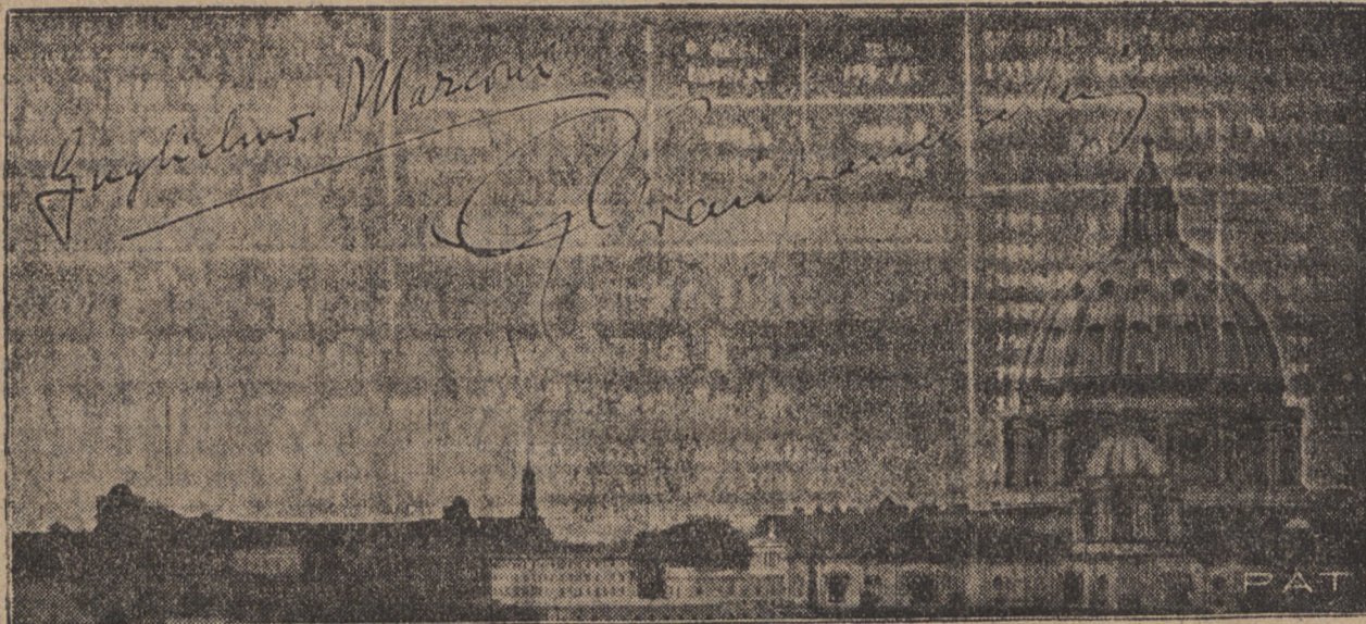
Radjotelefoniczna i radjotelegraficzna stacja watykańska, której uroczyste otwarcie nastąpiło w rocznicę koronacji Piusa XI — to jest 12 lutego br., jest jedną z najlepiej urządzonej i najsilniejszych stacyj na świecie. Zdjęcie: Ogólny widok Radjostacji Watykańskiej. Na prawo kopuła Bazyliki św. Piotra. U góry autograf znakomitego wynalazcy radjotelegrafji i r.-telefonji prezesa Włoskiej Akademji Nauk, senatora G. Marconiego oraz Dyrektora Radjostacji Watykańskiej Ojca Gianfrancesca.
