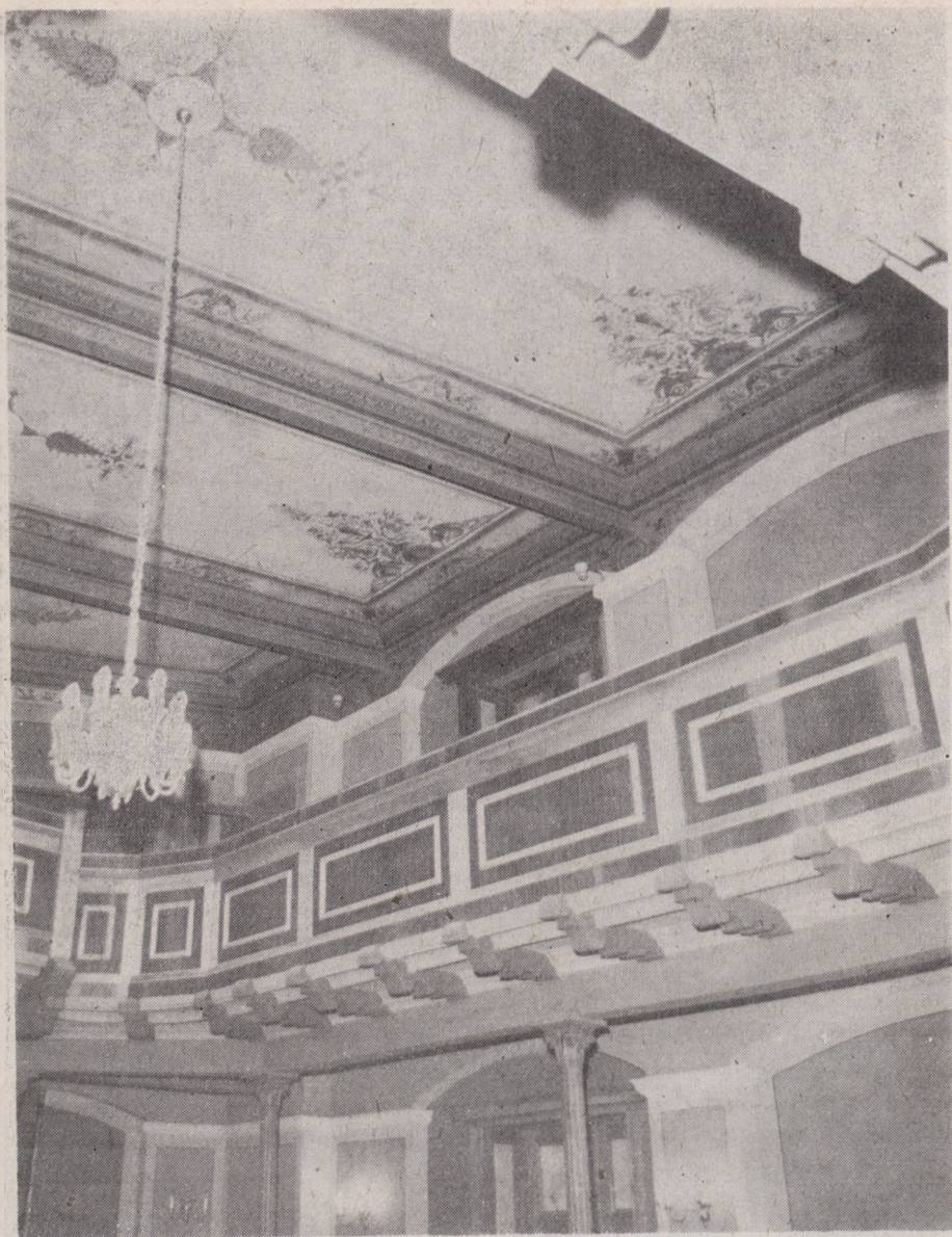
3. Sala kolumnowa, fragment stropu. Fot. Wiktor Najder
