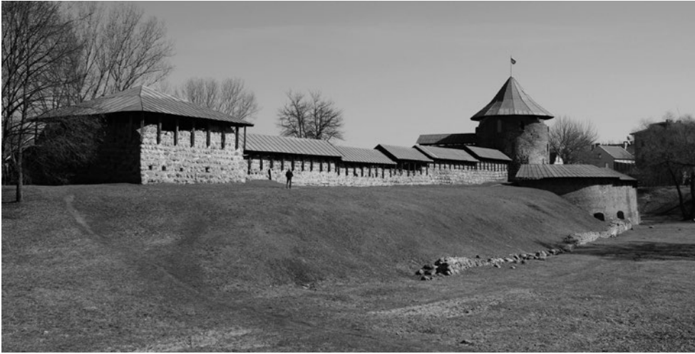
Ryc. 9.1. Zamek w Kownie – renowacja i adaptacja na potrzeby społeczeństwa, kwiecień 2009
