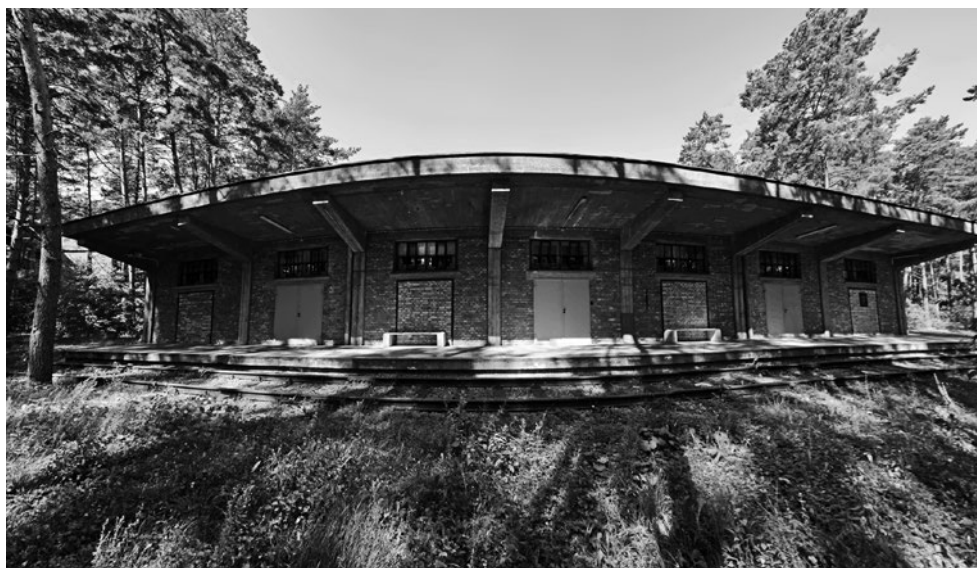
Ryc. 24.1. Budynek walcowni i magazynów 1157 (typ lekki). Fot. Wojciech Woźniak
