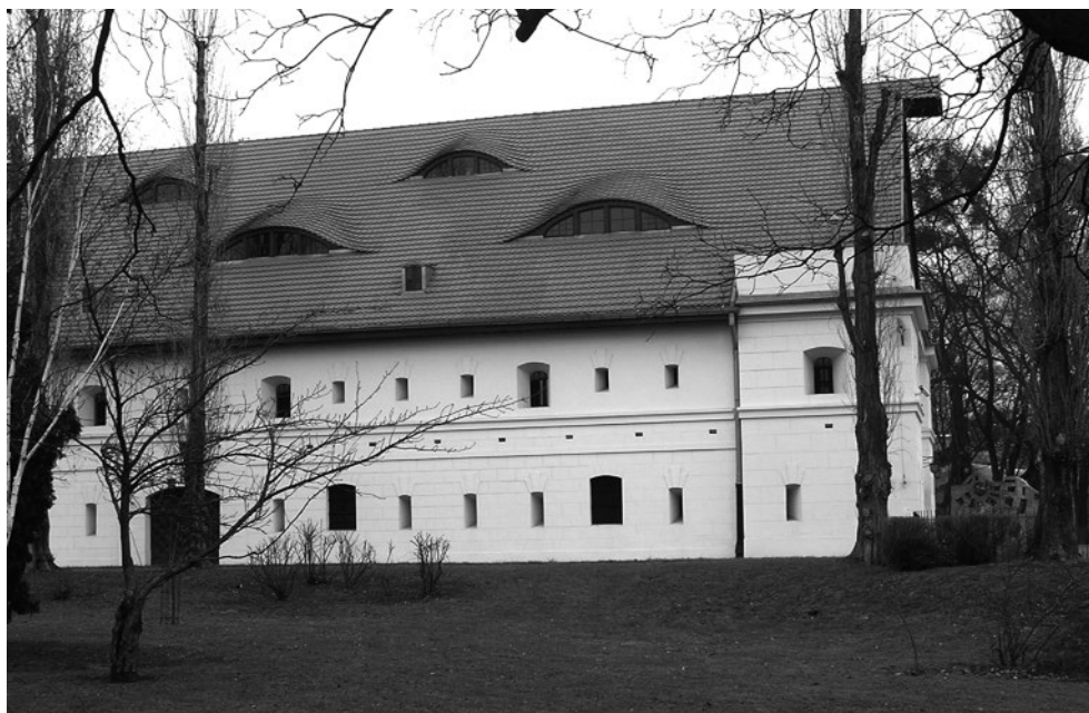
Ryc. 22.4. Fasada zachodnia – na parterze umieszczone wtórne okna. Fot. autor
