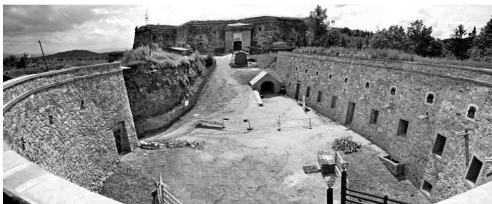
Ryc. 10.3. Bastion Dolny – odtworzenie lica murów dziedzińca w latach 2012–2013, gdzie ubytki sięgały nawet 2,5 m, sfinansowano ze środków MKiDN
