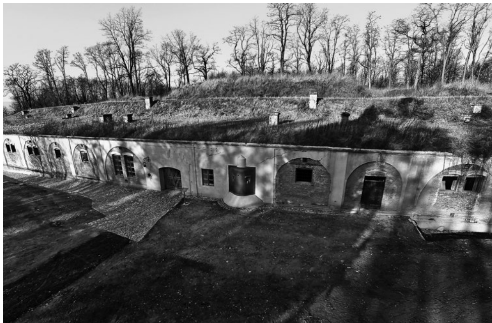
Ryc 5.4. Fort XI Duńkowicki zewnętrznego pierścienia fortyfikacji TP, widok od strony bramy prowadzącej na teren fortu, po pracach rewitalizacyjnych, 2015 r. Fot. ze zbiorów ZGFTP
