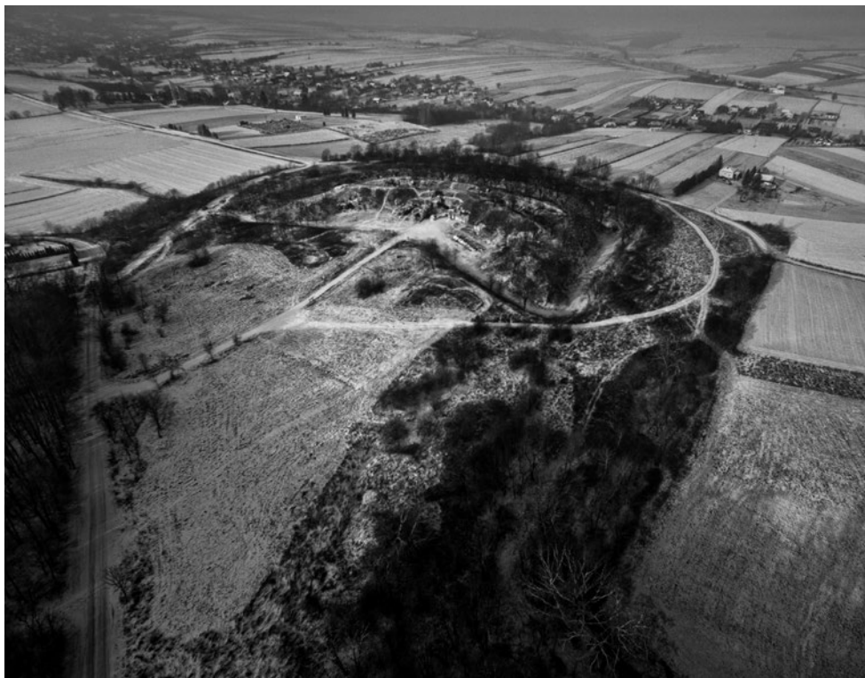
Ryc 5.3. Fort X Orzechowce zewnętrznego pierścienia fortyfikacji TP, z lotu ptaka, w scenerii zimowej, po wykonaniu prac rewaloryzacyjnych, 2015 r. Fot. ze zbiorów ZGFTP
