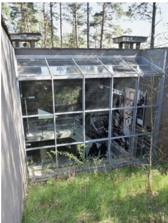
Ryc. 24.5. Jedno z trzech skrzydeł (Gwiazdy) budynku stabilizacji nitrogliceryny 1141 (typ ciężki). Fot. Andrzej Damian Borsuk
