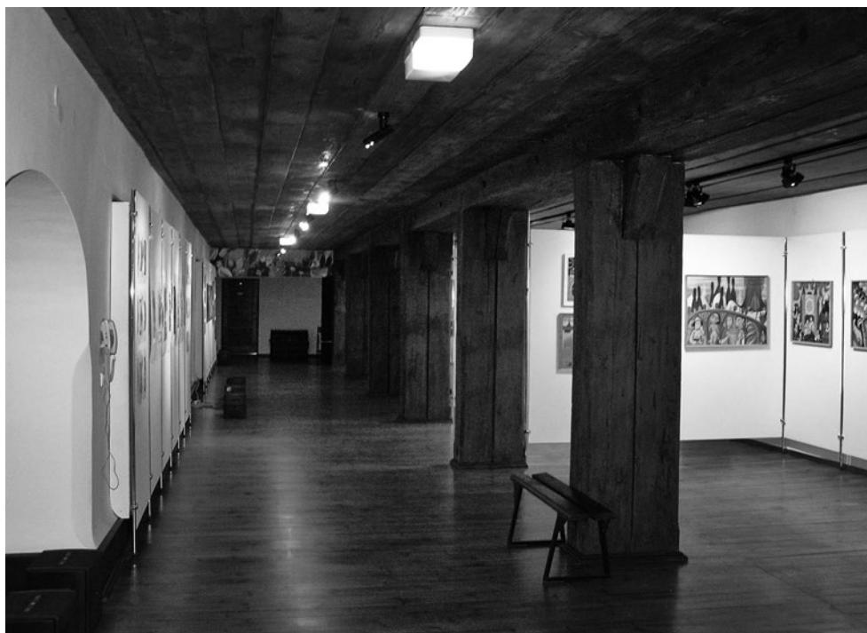
Ryc. 22.5. Widok wnętrza pierwszego piętra (obecnie sala wystawowa). Po lewej, umieszczony w osi symetrii mur arkadowy. Po prawej, rząd zdwojonych słupów podtrzymujących ciężar stropu bomboodpornego. Fot. autor
