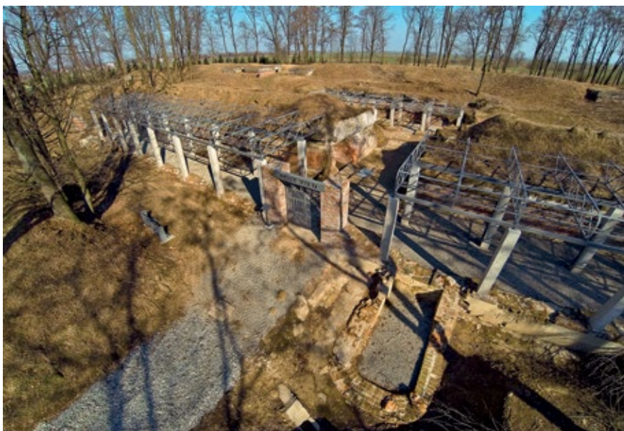
Ryc. 5.8. Fort XIIIb Bolestraszyce zewnętrznego pierścienia fortyfikacji TP, po pracach rewaloryzacyjnych, 2015 r., konstrukcja przeznaczona pod roślinność powtarza formę koszar sztytowych fortu, odsonięty narys kaponiery. Fot. ze zbiorów ZGFTP
