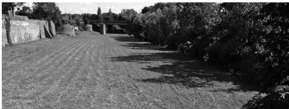
Ryc. 20.13. Stan wschodniej strony fortyfikacji Wału von Plauena ok. 2005 r. Fot. B. Jesionowski
