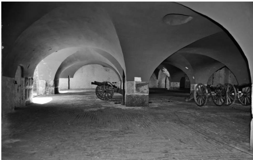
Ryc. 13.5. Gdańsk, Twierdza Wisłoujście. Kazamata Bastionu Furta Wodna, po pracach remontowo-konserwatorskich. Fot. Katarzyna Krawczyk, 2016
