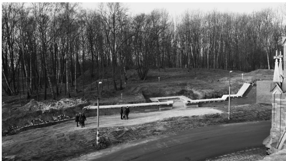
Ryc. 12.2. Fort 2 Kościusko, prace uczelniające zburzone bastiony, dotowane z NFOZK. Fot. H. Rojkowska
