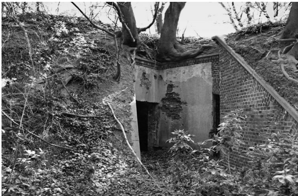
Ryc. 13.6. Gdańsk, Twierdza Wisłoujście. Wejście do magazynu prochowego na Bastionie Wiślanyłm Szańca Wschodniego, przystosowanego na zimowisko dla nietoperzy. Fot. Katarzyna Krawczyk, 2016
