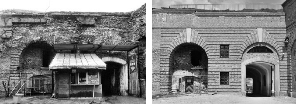
Ryc. 10.5. Donjon – kolejna uzupełniona elewacja dziedzińca, wraz z izolacją przeciwilgociową korony, pozwoliły na adaptacje wewnątrz do funkcji muzealnych i biurowych
