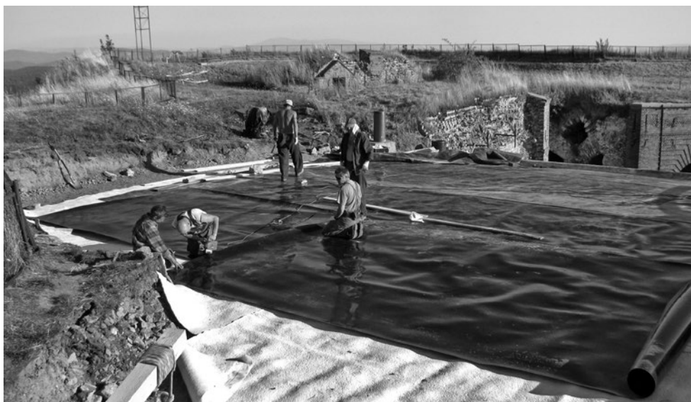
Ryc. 10.6. Donjon – do izolacji przeciwwilgociowych korony z sukcesem używane są geomembrany z folii PEHD o grubości 1,5 mm
