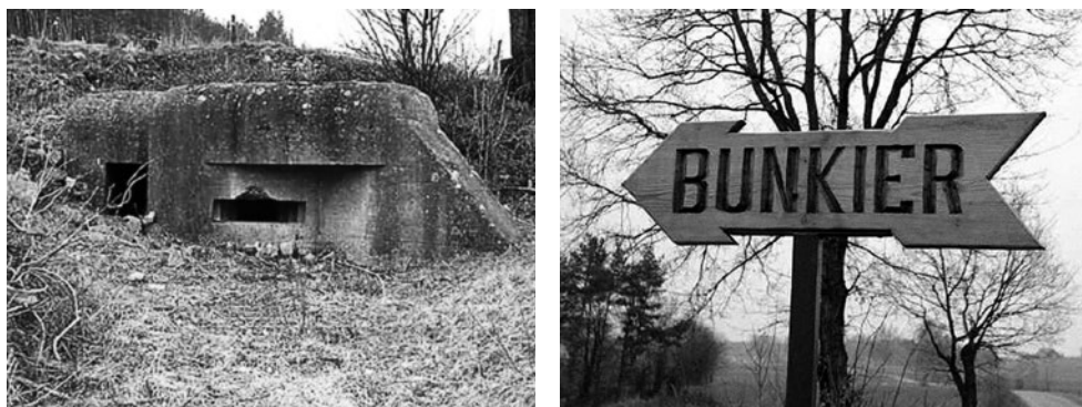
Ryc. 19.4. Pozycja Ryteł (Kęsowo): A – schron tradytorowy jednostronny, przy drodze na Kęsowo, B – oznaczenie dojścia do schronu. Fot. autor
