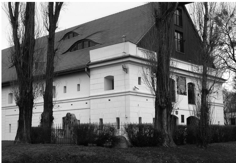
Ryc. 22.3. Fasada arsenatu od strony miasta – widoczne otwory drzwi na piętrze i poddaszu. Fot. autor
