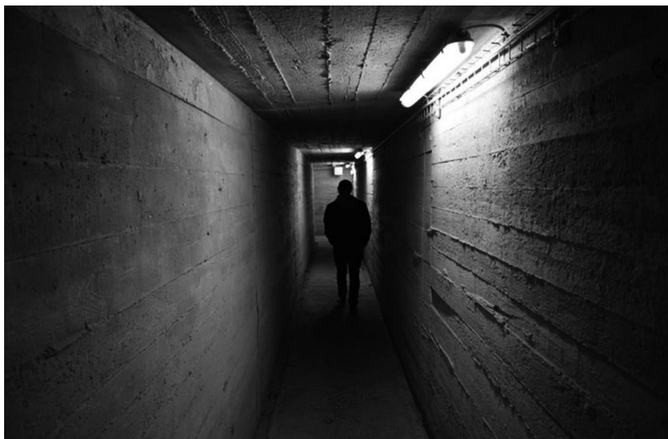
Ryc. 24.4. Tunel technologiczny. Fot. autor
