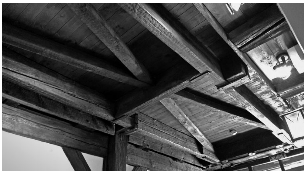
Ryc. 22.6. Widoczna od spodu opuszczana rampa prowadząca z parteru na piętro. W chwili obecnej zamocowana na stałe w pozycji poziomej. Fot. autor
