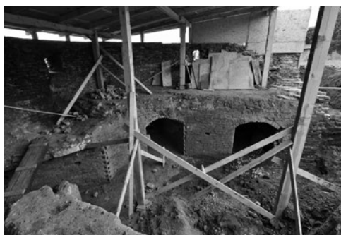
Ryc. 20.7. Wnętrze „bastei” nr 3. Widoczne otwory strzelnicze dolnej kondygnacji oraz pocienienie przez rozbiórką części muru dokonane przez Szwedów ok. 1630 r. Fot. L. Okoński. Zbiory fotograficzne MZM
