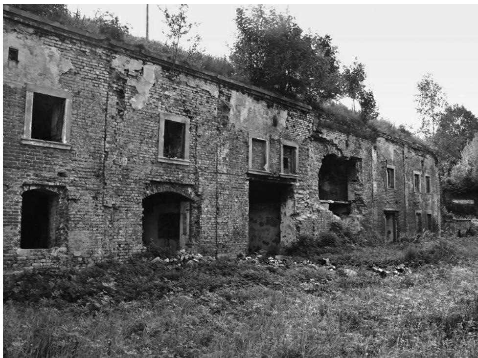
Ryc. 4.4. Fort Owcza Góra w Kłodzku. Dobrze zachowane do 1945 r. Koszary Czerwone fortu zostały w ciągu ostatnich kilku dziesięcioleci, w wyniku braku użytkowania i dewastacji, doprowadzone niemal do stanu ruiny. Fot. G. Bukal, 2007
