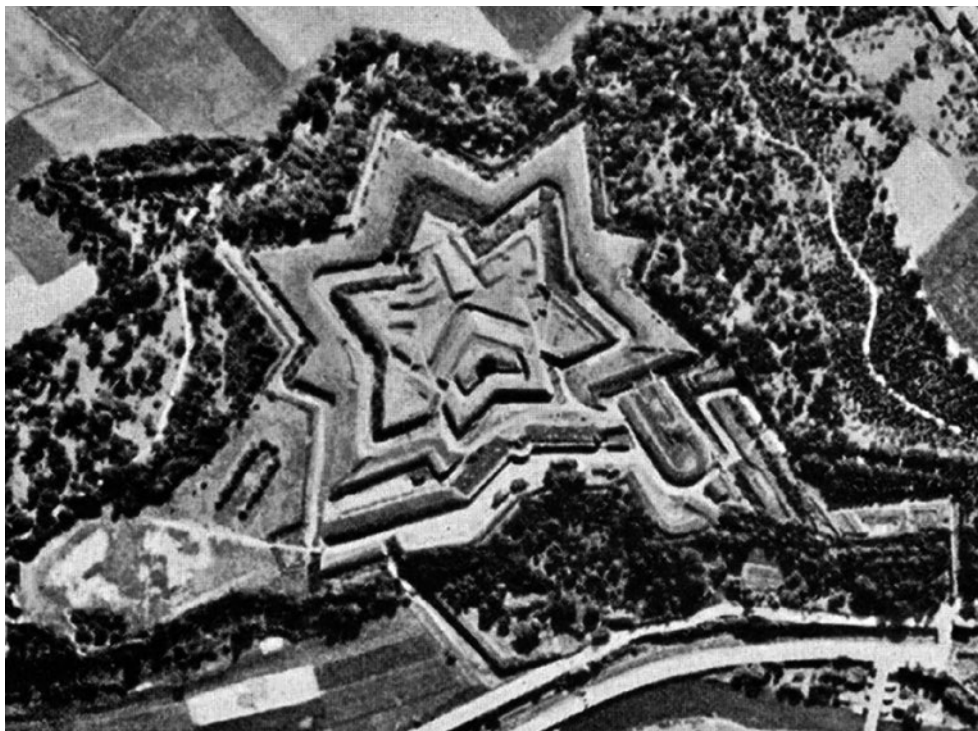
Ryc. 4.3. Fort Owcza Góra w Kłodzku. Fotografia lotnicza ukazuje w pełni zachowaną, czytelną strukturę fortu. Fot. sprzed 1945, kopia w zbiorach Katedry Historii, Teorii Architektury i Konserwacji Zabytków Wydziału Architektury Politechniki Gdańskiej
