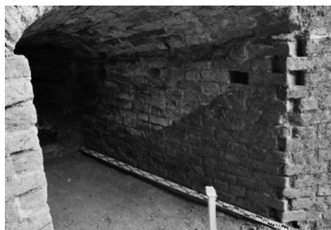
Ryc. 20.8. Widok jednego z otworów strzelniczych w „bastei” nr 3. Zachowane wymurowane gniazda do mocowania broni palnej. Fot. L. Okoński. Zbiory fotograficzne MZM
