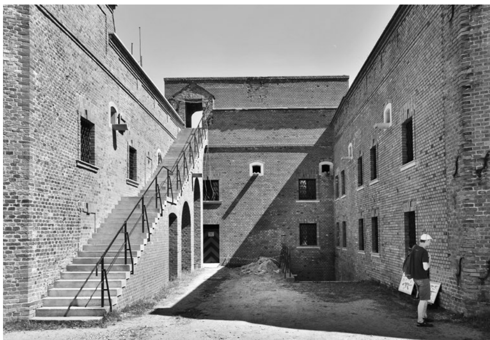
Ryc. 10.2. Donjon – zestawienie przed po pracach ratunkowych i restauratorskich elewacji tzw. południowej kieszki Donjonu 2008–2010. Wsparcie ze środków MKiDN
