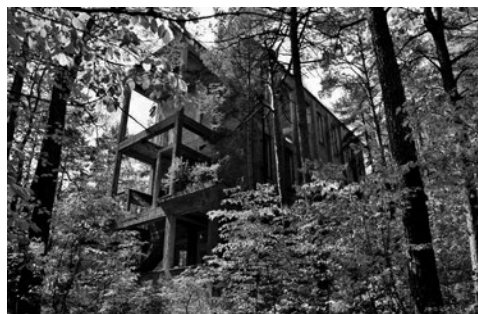
Ryc. 24.3. Budynek zatężalni kwasu azotowego 1123 z III strefy. Fot. autor
