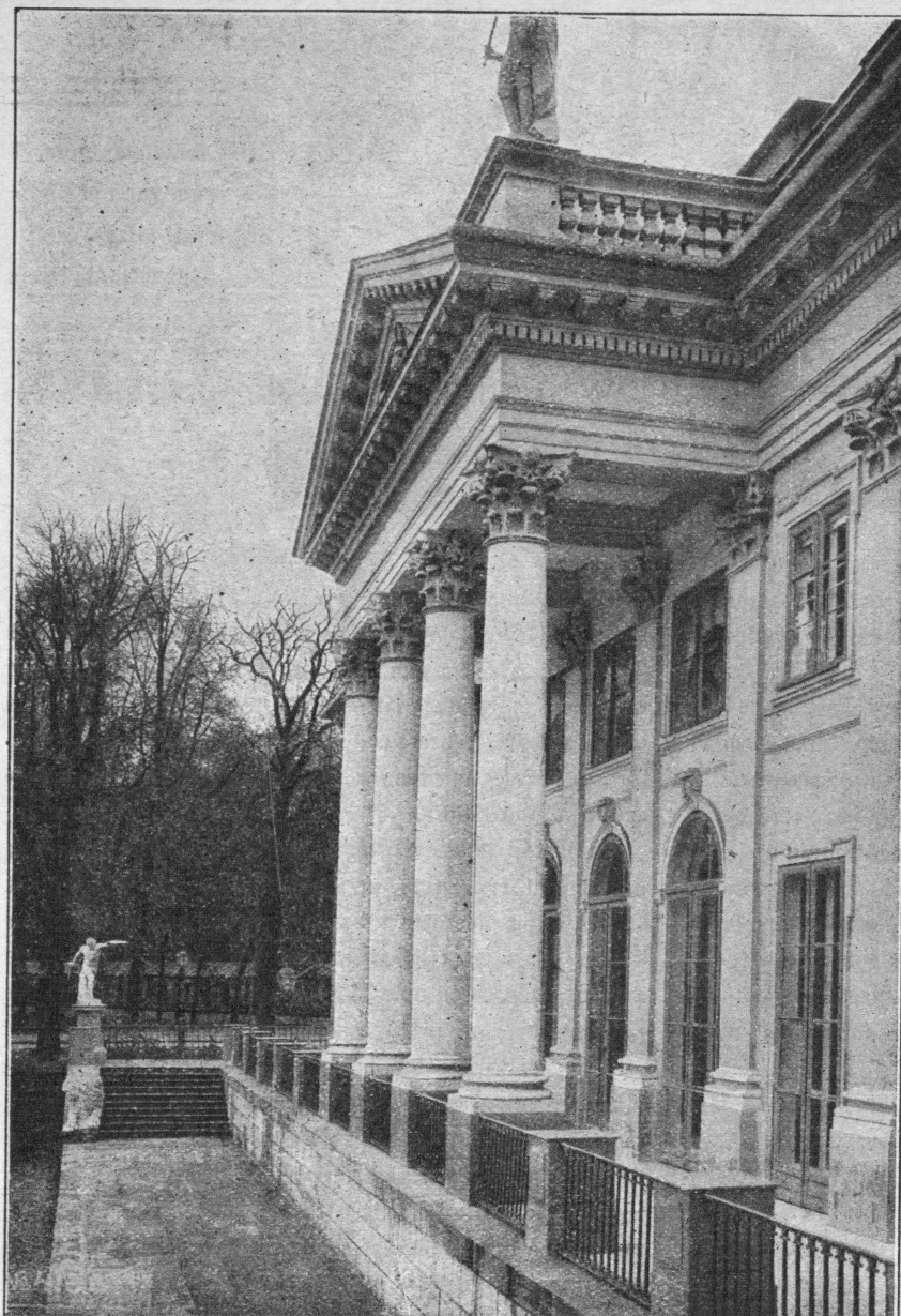
Pałac od strony północnej.
