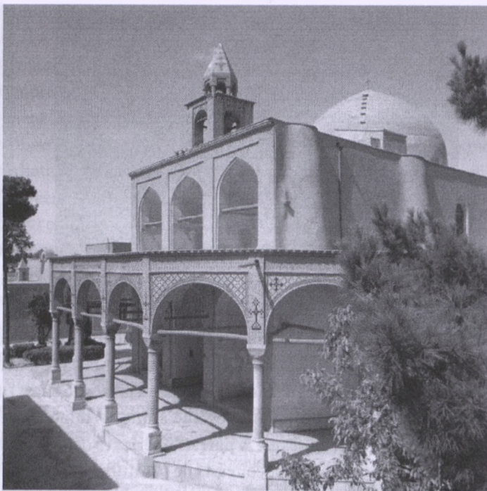
Fig. 5. Eglise "estivale" au sud de l'église Saint Minas, vue sud-ouest
