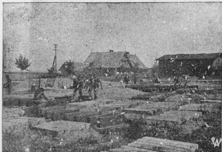
Budowa szosy asfaltowej na półwyspie Helski od Wielkiej Wsi Hallerowej postępuje rażąco naprzód, dzięki staraniom p. wojewody pomorskiego St. Kirtiklisa, oraz władz lokalnych z p. starostą morskim St. Wendorffem na czele. Zdjęcie przedstawia fragment prac w betoniarni w Wielkiej Wsi Hallerowej, wykonywane są krawężniki betonowe dla szosy helskiej w liczbie 72 tysięcy. Niezależnie od tego drużyny pracy wykonują betonowe chodniki dla poszczególnych gmin półwyspu Helskiego. Wszystkie bowiem gminy nadmorskie otrzymują począwszy od Wielkiej Wsi Hallerowej asfaltowe ulice i chodniki betonowe.
