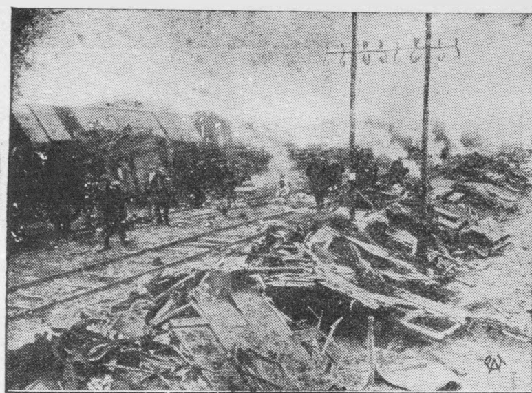
Święta Bożego Narodzenia upłynęły w całej Francji pod znakiem żałoby z powodu niebywałej katastrofy kolejowej w Lagny. Katastrofa wydarzyła się w Wilje około północy pod stacją Lagny, gdzie na zatrzymanym pod sygnałem pociąg wpadł z całym rozpędem, idący z szybkością 105 km. na godzinę pociąg kurierski. Skutki zderzenia były straszne, kilka wagonów zostało rozbitych doszczętnie. Liczba ofiar przewyższa 500 osób w czym zgórą 200 zabitych i przeszło 300 rannych. Na zdjęciu — miejsce katastrofy.
