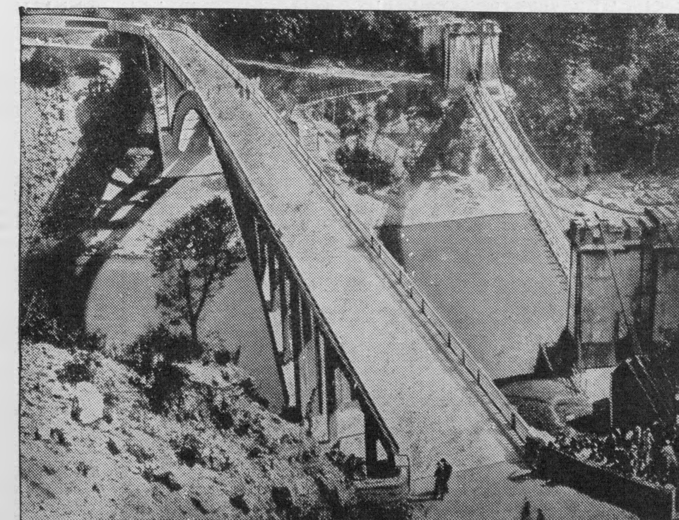
Ponad dolinę Tal, dzielącą północne Indie od Tybetu, zbudowano ostatnio nowoczesny most łukowy, który zastąpi dotychczasowy most wiszący (na prawo).
