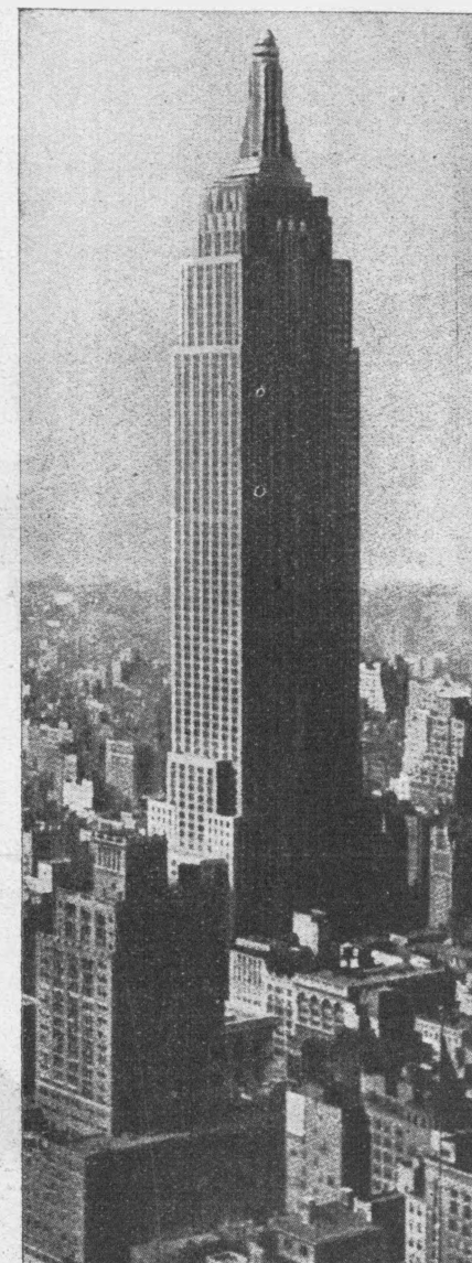
W New-Yorku na skrzyżowaniu 5 Avenue i 34 ulicy ukończono najwyższy „drapacz chmur” na świecie. Ma on 85 pięter, pozbawiony zawiera 30-metrową wieżę z obrotową kopułą, jako stację dla Zennopław
