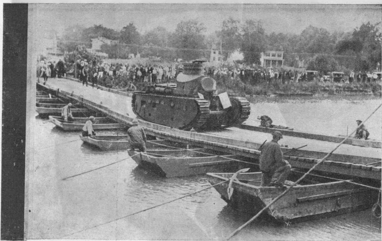
Most pontonowy, zbudowany przez amerykańskiego inżyniera, wytrzymuje przejście najcięższego tanka.
