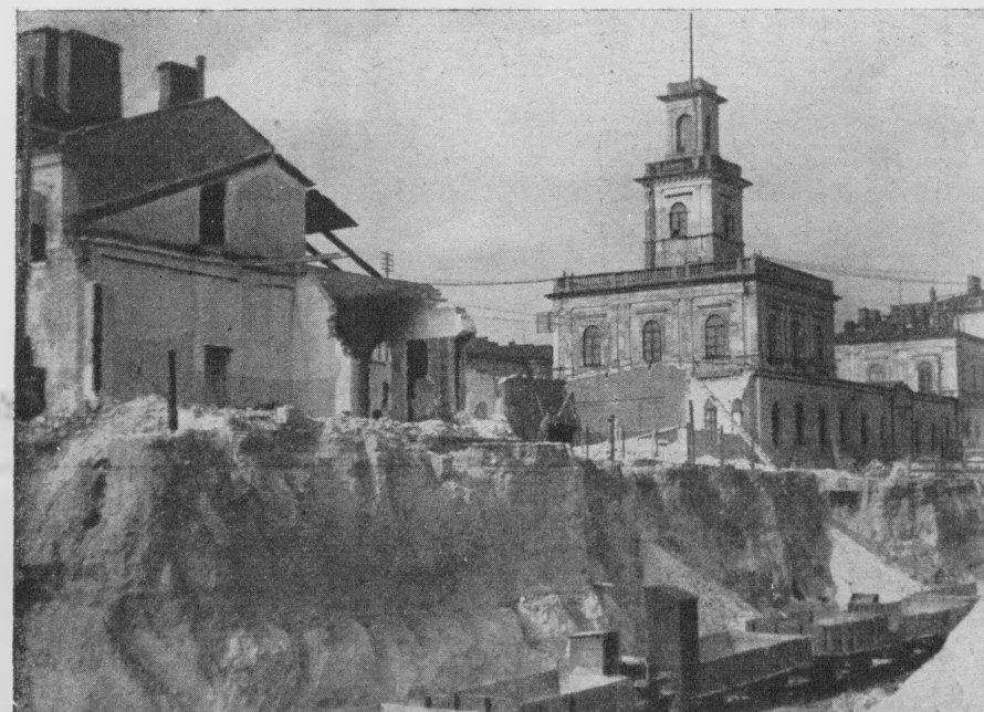
Linja średnicowa w Warszawie. Tunel, prowadzony od Wisły, z drugiej strony od ul. Towarowej złączył się przy Dworcu Głównym, którego budynki rozpoczęły rozbierać.
