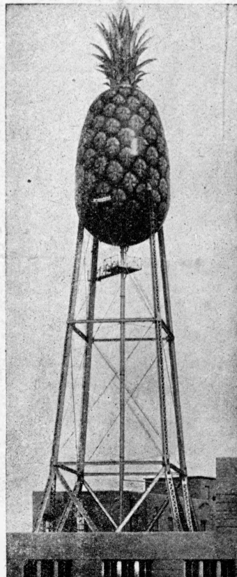
Wieża ciśnieniowa zbudowana w kształcie ananasa. Wieża ta ze stali mieści w sobie 100.000 galonów wody.
