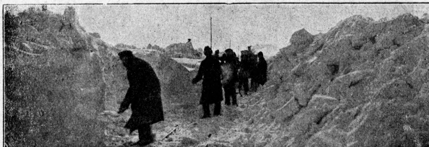
200 robotników odkopuje tor kolejowy kolejki kalisko-tureckiej
