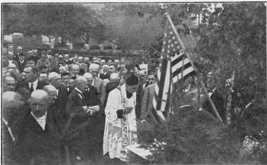
Poświęcenie kamienia węgielnego pod nową Elektrownię Miejską w Ostrowie Wlkp, w dn. 16.VII. 1927.
