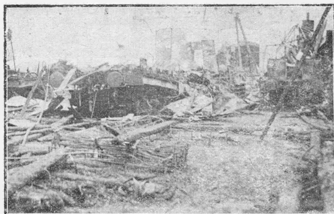
Dnia 13 maja spaliły się na Dworcu Warszawa Wschodnia warsztaty kolejowe. Straty wynoszą około miliona złotych. Zdjęcie przedstawia miejsce spalania.
