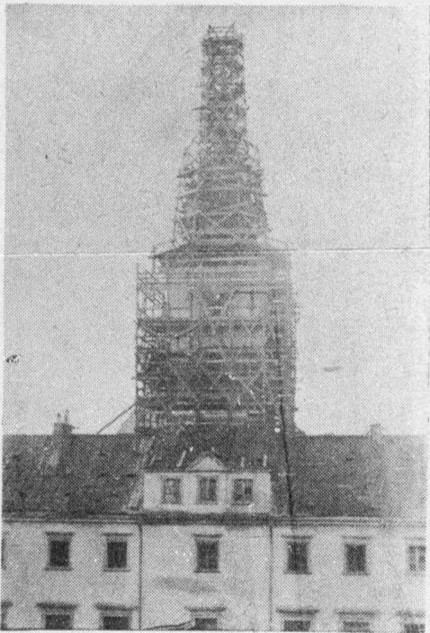
Remont wieży zegarowej.
