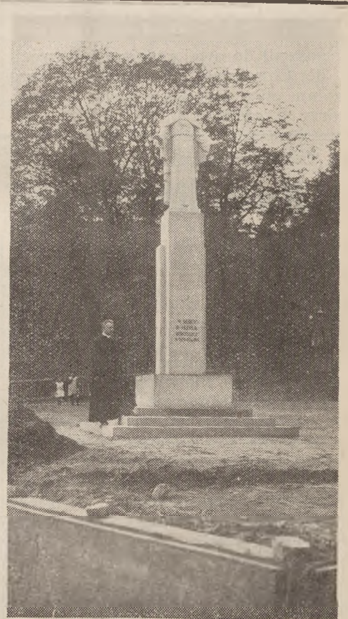
Jubilat przy budowie pomnika Serca P. Jezusa na placu Poznańskim.
